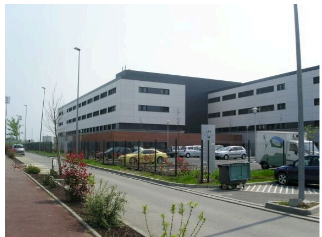
Site de la Haute-Garonne et siège de l'Urssaf Midi-Pyrénées depuis le 1 er janvier 2012. Bâtiment situé 166 rue Pierre et Marie-Curie à Labège innopole.
